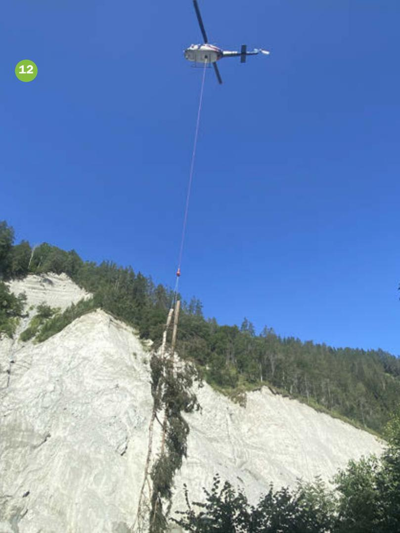
Dans la vallée de St. Nicolas, l'intervention principale a consisté à dégager un embâcle sur la Vispa. Après que l'hélicoptère ait extrait un maximum de débris, les matériaux restants ont dû être désimbriqués à l'aide d'un treuil de câble-grue conventionnelle avant d'être évacués. Ce travail très spectaculaire dans le lit de la rivière a nécessité des compétences techniques particulières.
