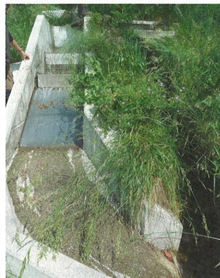
Hier eine Einspeisestelle in das Bewässerungssystem der BLS. Das Wasser wird gesiebt, die Feststoffe und überschüssiges Wasser gelangen automatisch in den Rüssschlag oder die Suone zurück.
