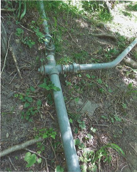
Das Bewässerungssystem umfasst total etwa 80 km Leitungen. Die Sprühdüsen sind direkt in die Rohre eingeschraubt, abwechselnd eine hangaufwärts und eine hangabwärts gerichtet.
