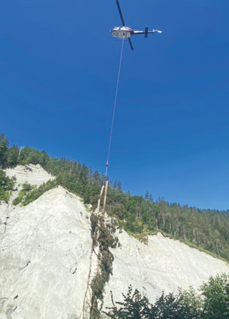
Im Mattertal bestand der Haupteinsatz in der Beseitigung einer Verklausung in der Vispa. Nachdem der Helikopter so viel Material wie möglich entfernt hatte, musste das restliche Material mit der Winde eines konventionellen Seilkrans gelöst und abtransportiert werden. Diese sehr spektakuläre Arbeit im Bachbett erforderte besonderes technisches Geschick.
